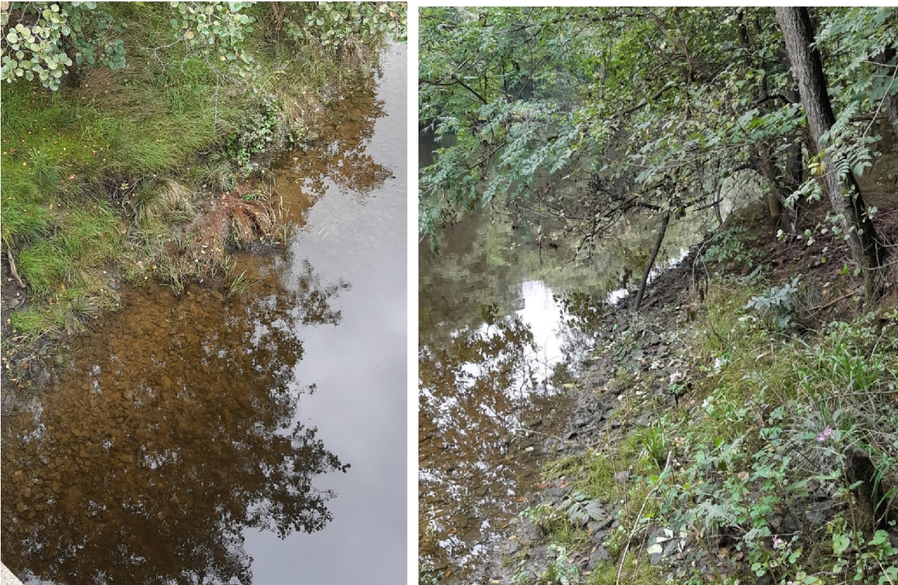
Figur 8. T.v. Erosionsskydd under vattenytan i områdets östra del (kring sektion K9, K13 och K13b). T.h. Erosionsskydd ovan strandlinjen i den västra delen av området (kring sektion K14). Foton vid besiktning 2023-09-12.
